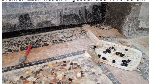
Afbeelding 3: Herstel van de beschadigde Terrazzo vloer in het gebouw Justitie
